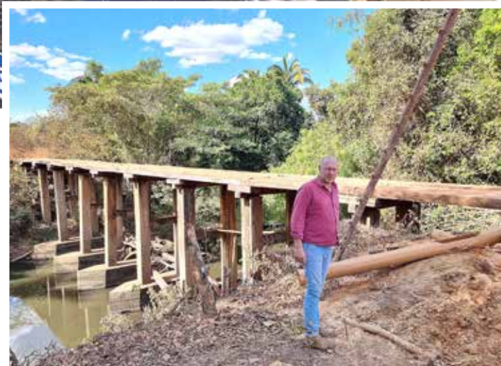
Ponte de madeira no Soninho será substituída por uma de concreto
