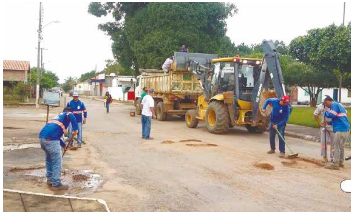
Ruas e avenidas de Tupirama foram recuperadas durante manutenção realizada pela prefeitura
