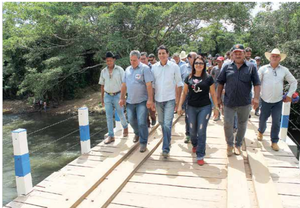
Ponte do rio Bananal, entre Colméia e Goianorte, foi reconstruída e tirou moradores do isolamento
